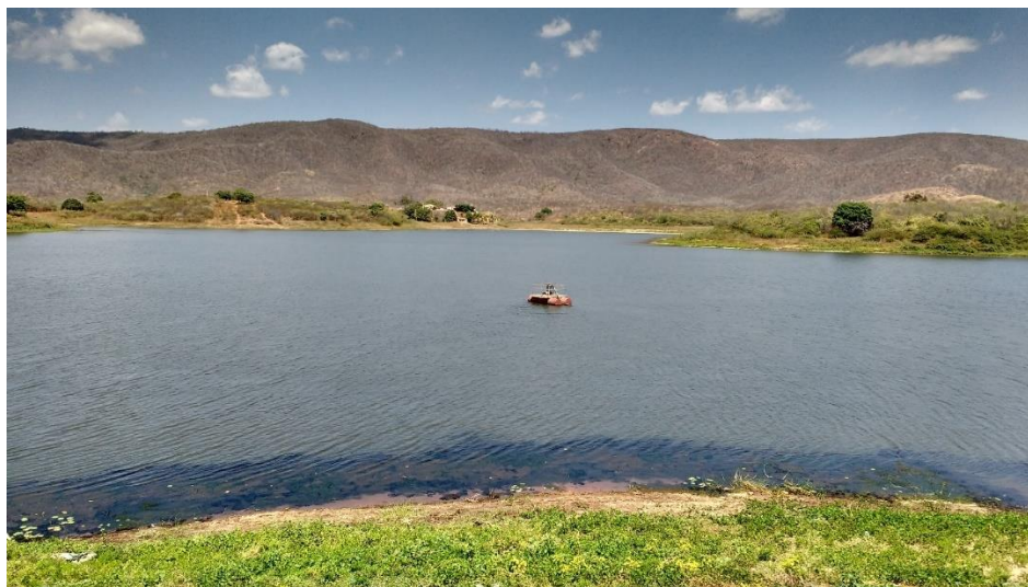
Figura 11 - Vista da bacia hidráulica da Barragem Junco
