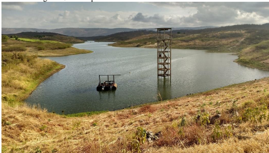
Figura 18 - Vista para montante do reservatório Manoel Balbino
