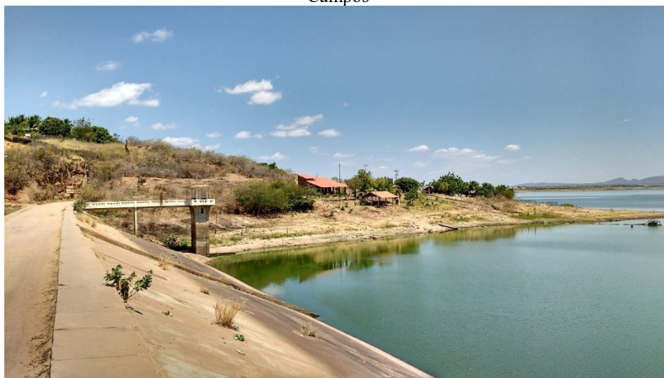
Figura 14 - Vista da ombreira direita, talude de montante e margem com ocupação antrópica na Barragem Lima Campos
